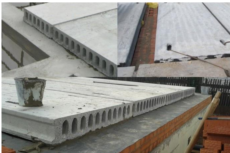
Рисунок 2 - Перекрытия из плит ПБ
