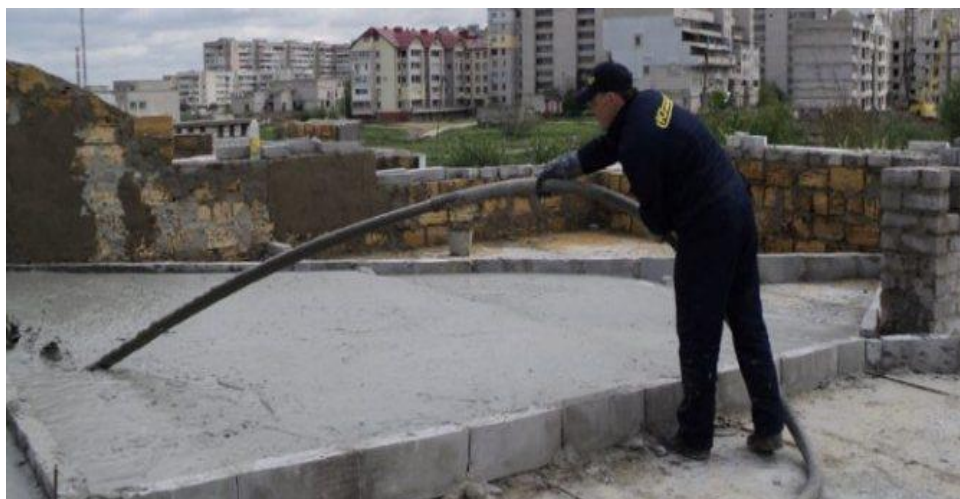
Рис. 3 – Пример заливки неавтоклавног пенобетона «на месте»
